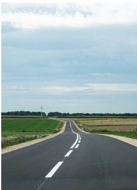
Droga powiatowa Dąbrowa Wielka-Bryki
